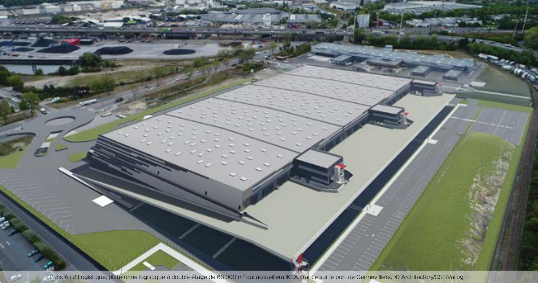
Paris Air 2 Logistique, plateforme logistique à double étage de 63 000 m² qui accueillera IKEA France sur le port de Gennevilliers. © Archifactory/GSE/Vailog.
